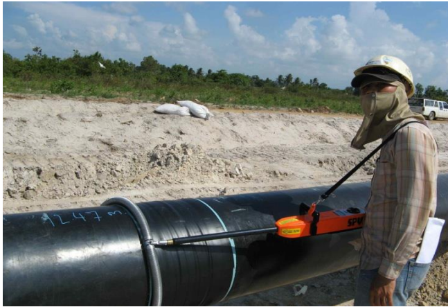
בדיקת רציפות הציפוי (Spark Test)
