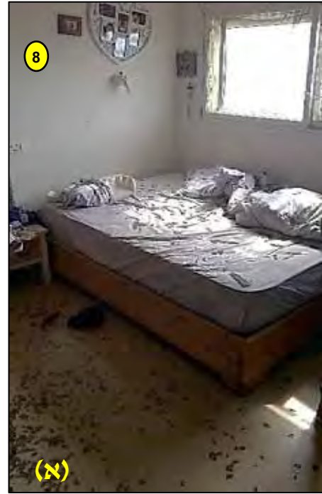
תמונה 8. פגיעות הדף במבנים (110 מ') - מבנה מגורים 5 : (א) שבר תריסים/משקופים, ניפוץ חלונות (ב) עקירת רעפים (ג)-(ד) נזקים מבניים בקירות/תקרות הבית
