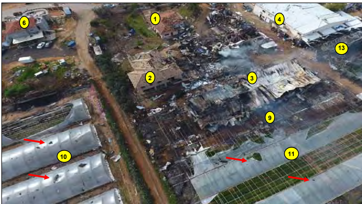
תמונה 11. מבט על אזורי פגיעת הרסיסים מכיוון החממות : ניתן לראות מהשמדה טוטלית של המבנים ע"י הדף ורסס עד לקרעים כתוצאה מרסיסים ורגמות שהושלכו.
