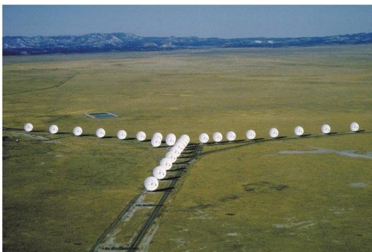
מערך מבוזר VLA (Very Large Array) בנוי מכסיקו המורכב מ-27 צלחות
